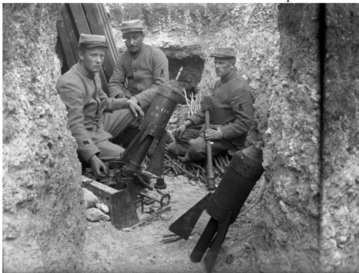
Cliché d'artilleurs de tranchée autour d'un crapouillot
