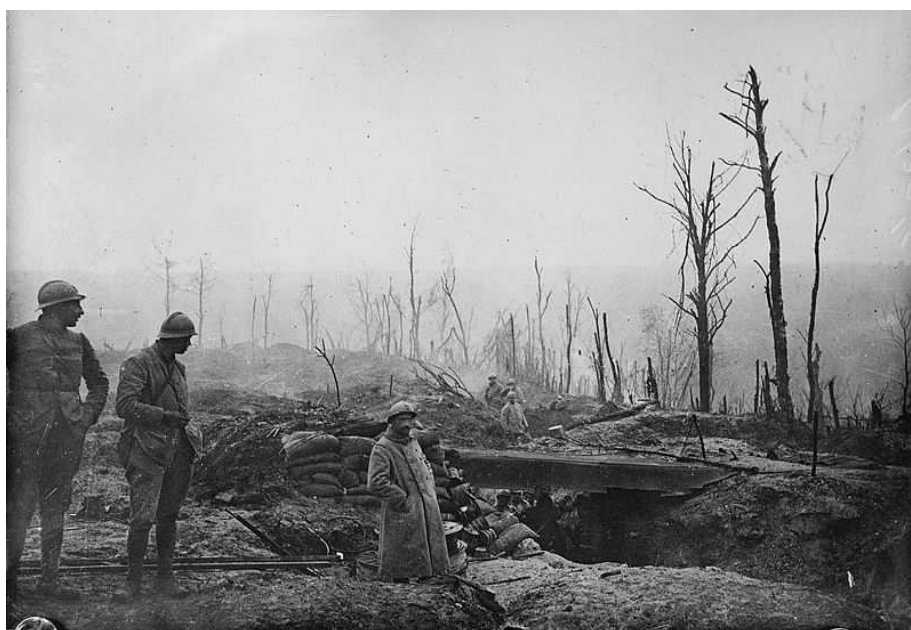
Une tranchée française en 1916.
