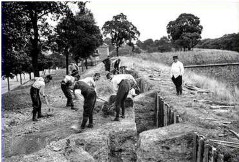
Camp retranché de Paris, construction de la tranchée allant de la porte de Châtillon à Charenton, juillet 1915.
